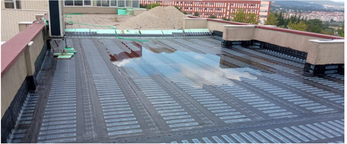
Dış Hekimliği Fakültesi onarımına ait görsel
