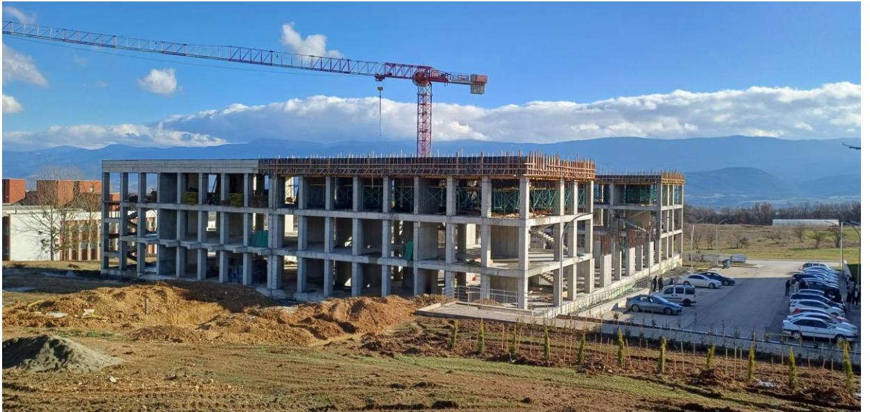
Merkezi Derslik Binasına ait görsel
